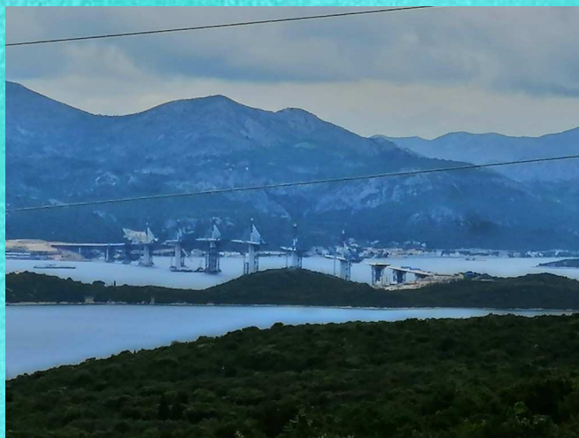
Die neue Brücke zur Verbindung Kroatiens
